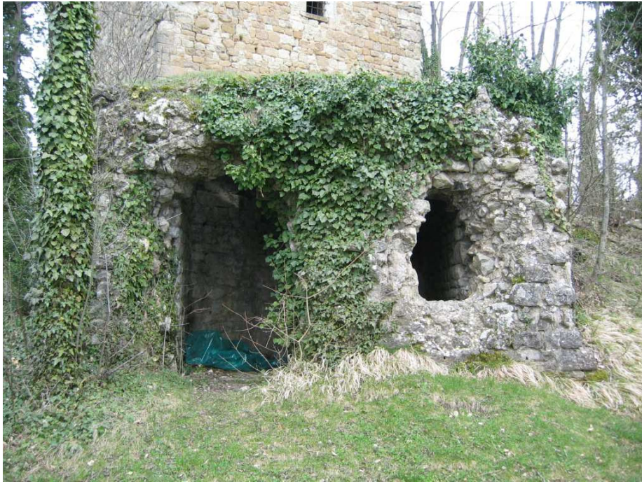
Foto n. 74: Torricella. Cisterna ai piedi della torre
