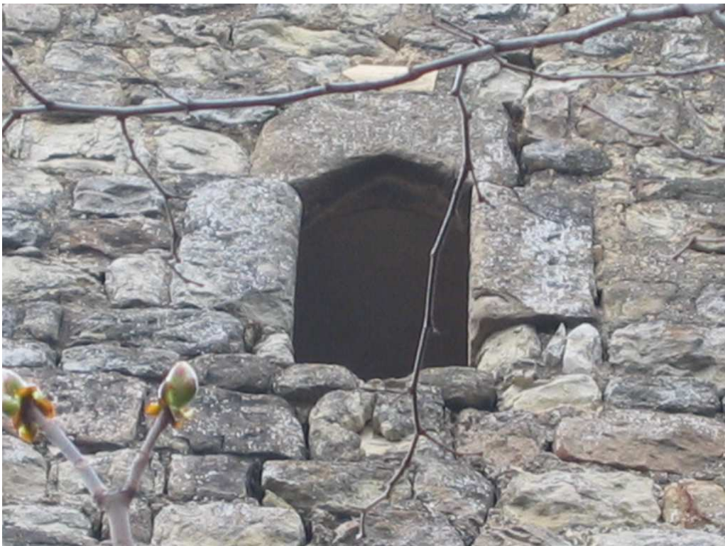
Foto n. 67: Torricella. Finestra all'ultimo piano della torre
