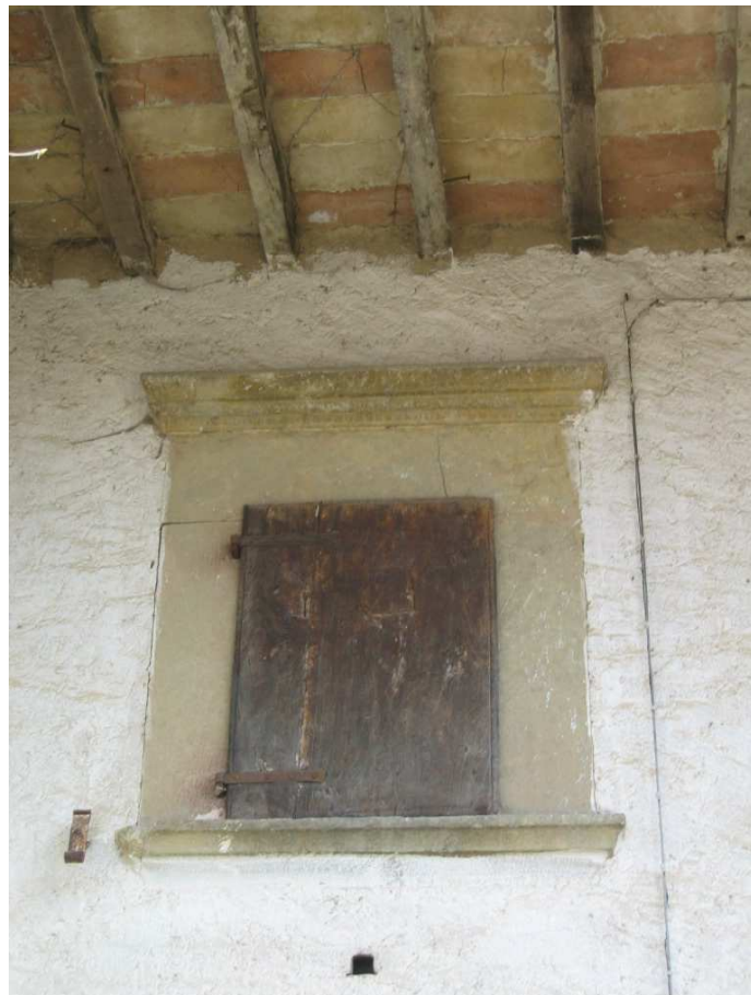
Foto n. 29: Il Casino. Casa a balchio, finestra rinascimentale
