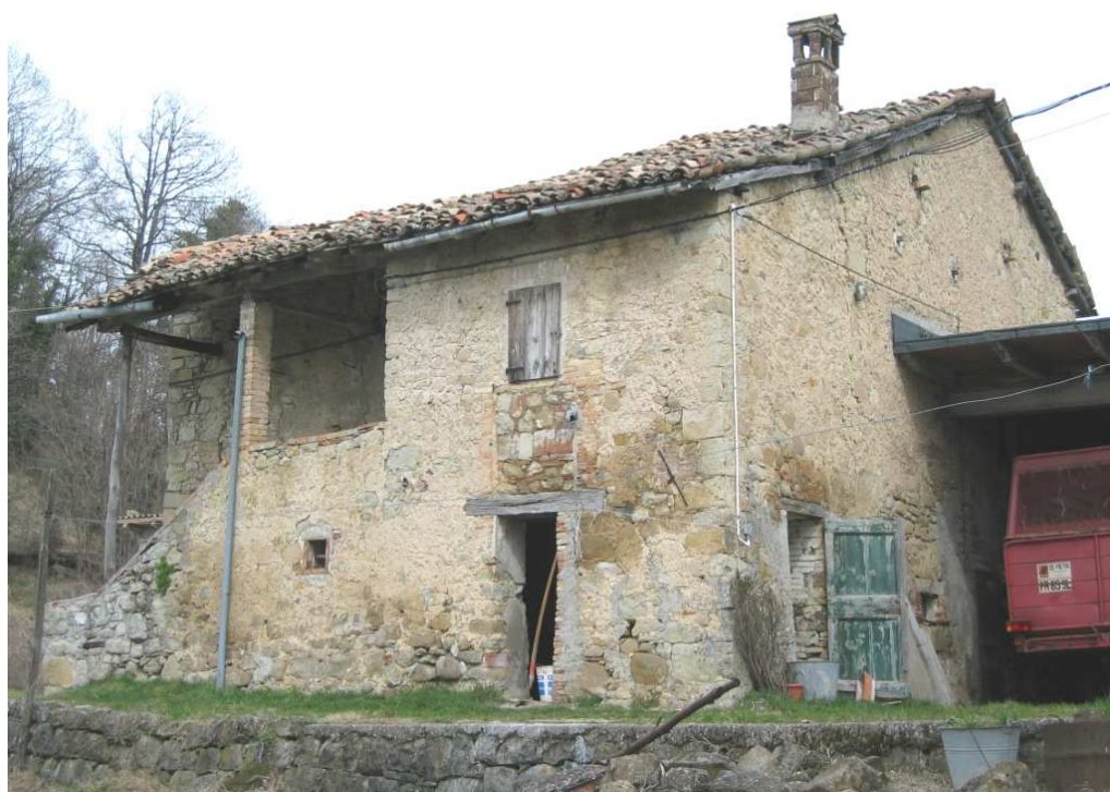
Foto n. 21: Miralago. Casa a balchio porticato.
