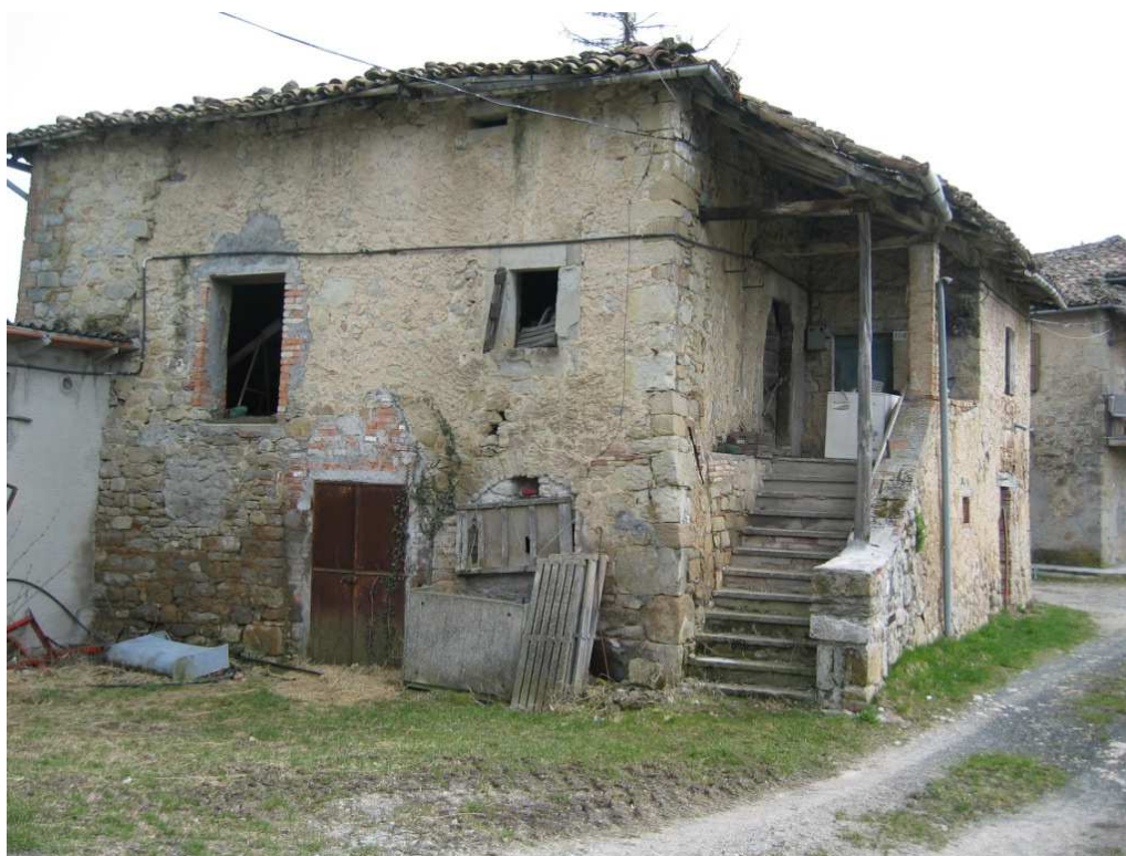
Foto n. 13: Miralago. Casa a balchio porticato.
