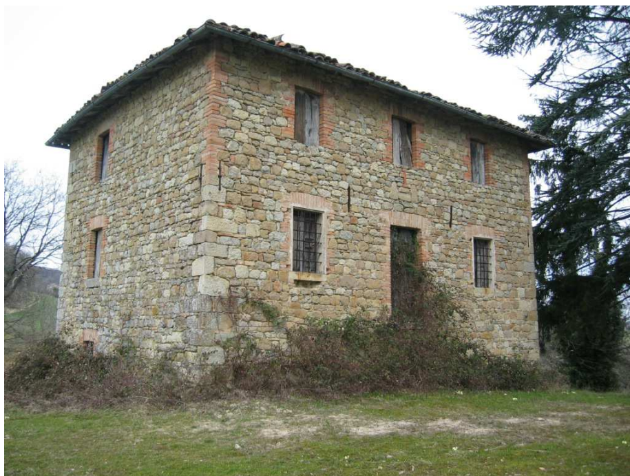
Foto n. 77: Torricella. Edificio in prossimità della torre
