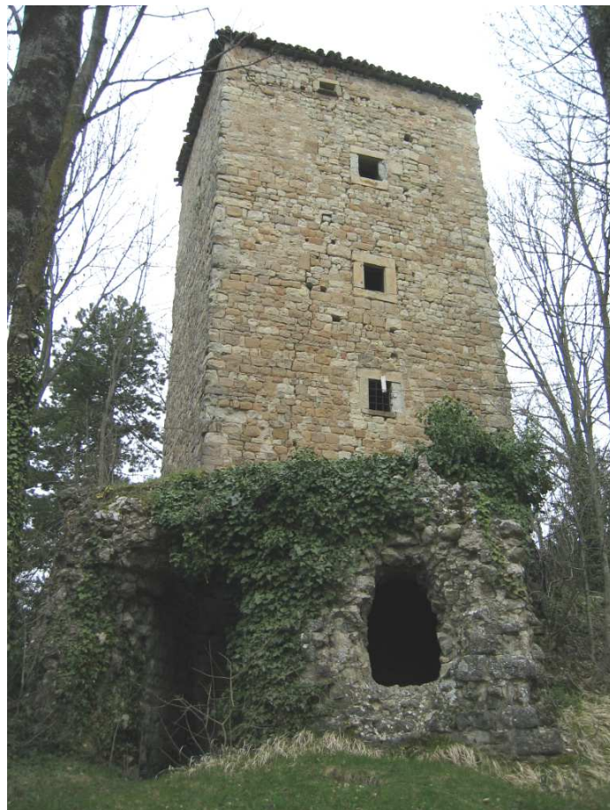
Foto n. 65: Torricella. Torre. Lato sud con cisterna
