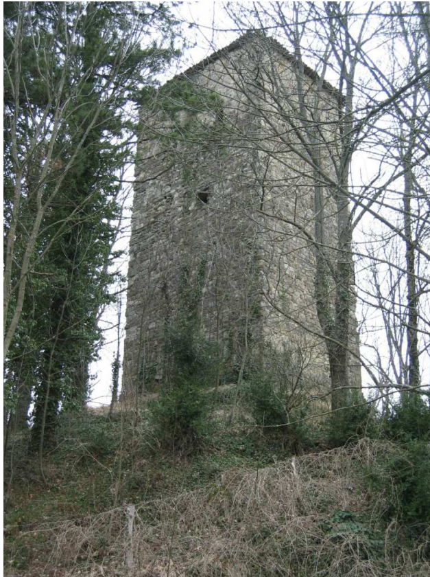
Foto n. 71: Torricella. La torre
