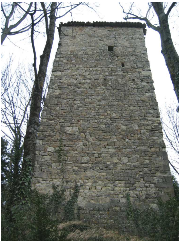
Foto n. 72: Torricella. La torre
