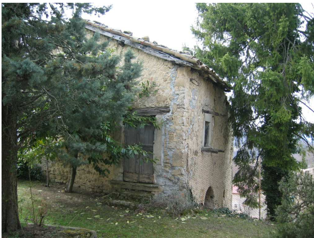
Foto n. 9: Miralago. Edificio rurale del XV sec.
