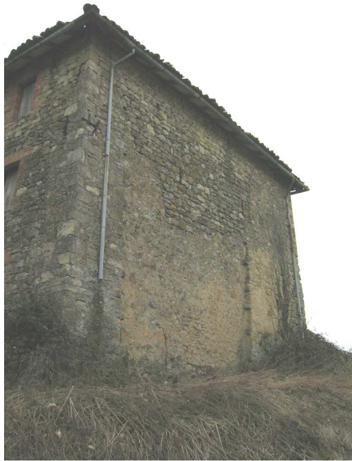
Foto n. 76: Torricella. Edificio in prossimità della torre
