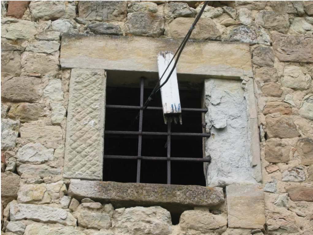
Foto n. 66: Torricella. Una finestra della torre
