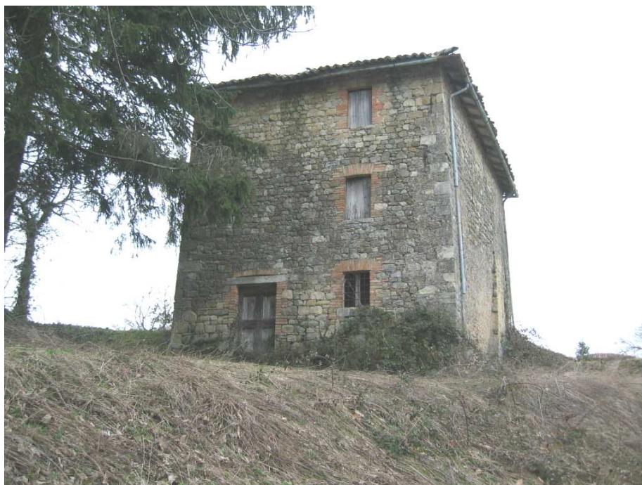
Foto n. 75 Torricella. Edificio in prossimità della torre
