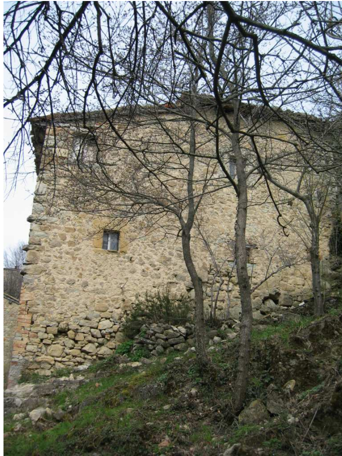
Foto n. 19: Miralago. Edificio rurale del XV sec
