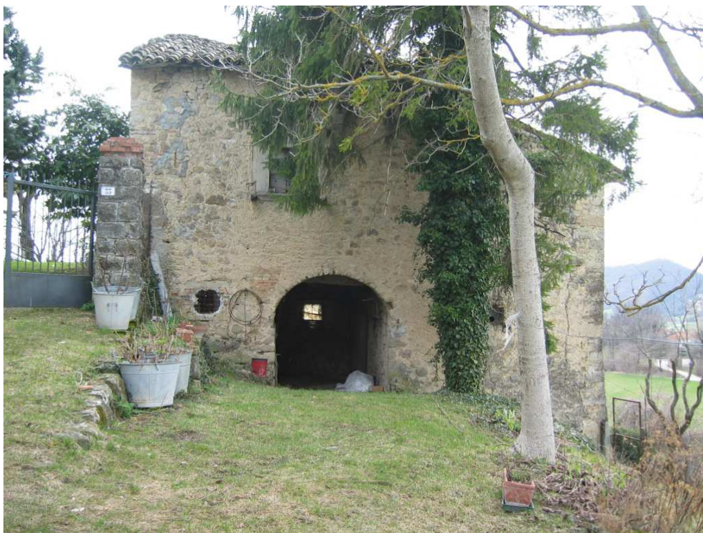
Foto n. 12: Miralago. Edificio rurale del XV sec.
